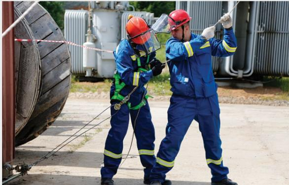
Этап № 3: Замена поврежденного провода на воздушной линии 0,4 кВ
